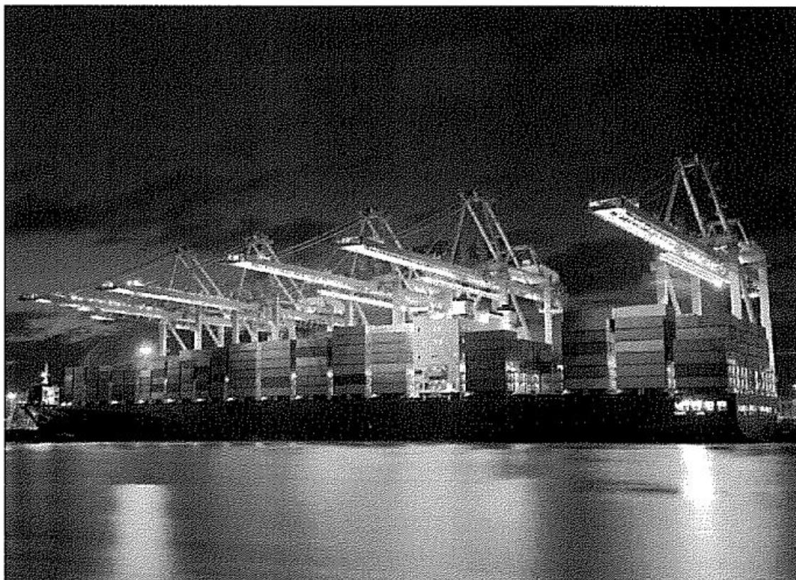
Рисунок 5.20: Электрические причальные краны
